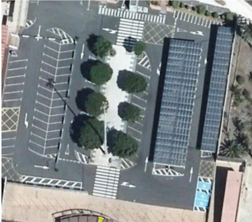
Figura 3.10. Parking fotovoltaico en INFECAR
