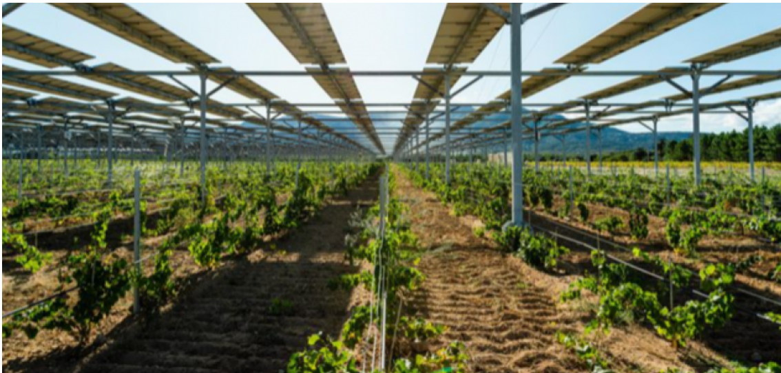
Figura 3.15. Estructuras fotovoltaicas sobre cultivos a cielo abierto (sin invernadero)
