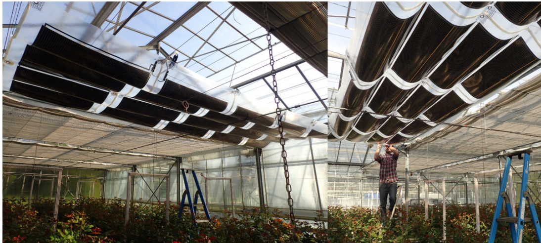
Figura 3.12. Invernadero fotovoltaico con paneles flexibles
