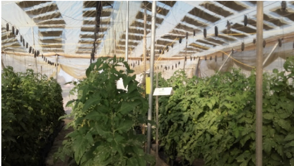
Figura 3.13. Invernadero fotovoltaico de tomates en Agadir
