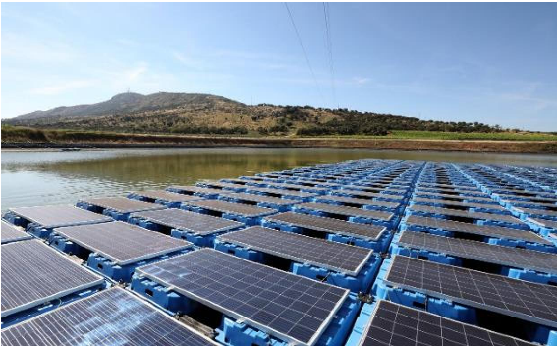
Figura 3.1 Planta de energía solar flotante en España
