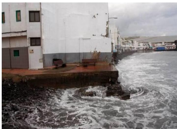
Figura 94. Vivienda afectada por la erosión de la playa en Ojos de Garza (Telde, Gran Canaria).
